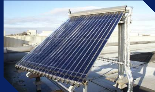
1.0 kWp solar thermal 1.0KWp太陽熱温水器
